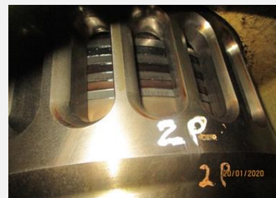
(適合油使用後約1ヶ月の主機掃気室)
